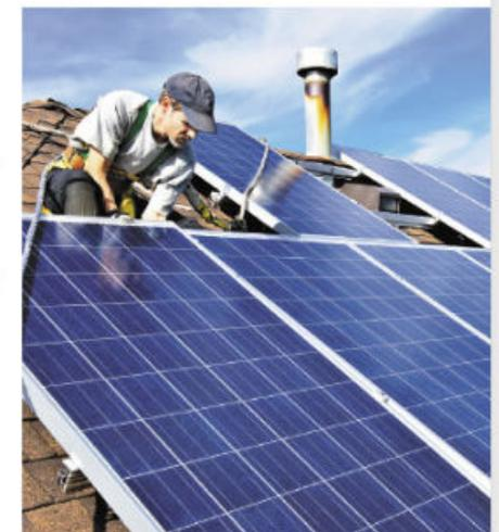
**Figura 4.39** Los paneles fotovoltaicos se forman de un conjunto de celdas que producen electricidad a partir de la luz solar que incide sobre ellos.
